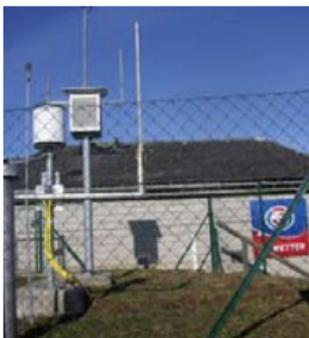
2004 wurde die 1. Ö3 Wetterstation in Frankenmarkt eröffnet. Hier werden Luftfeuchtigkeit, Regen- und Niederschlagsmenge, Lufttemperatur, Windrichtung, Luftdruck, Windgeschwindigkeit und Globalstrahlung (Helligkeit) gemessen. Alle Daten werden vollautomatisch an die Zentralanstalt (ZAMG) weiter übermittelt und im Rechner eingespeist, um von Fachleuten ausgewertet zu werden.
